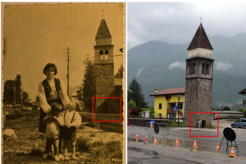
fig. 33 Confronto fra una foto degli anni '50 ed oggi del campanile al centro del sinkhole. L'altezza della porta è diminuita per effetto dei cedimenti e tentativi di stabilizzare la struttura del campanile riportando materiale.
